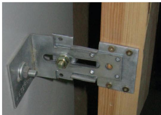
**Fig. 29** Attaches métalliques pour la fixation des chevrons.
