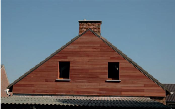
Fig. 35 Bardage posé par rainures et languettes.
