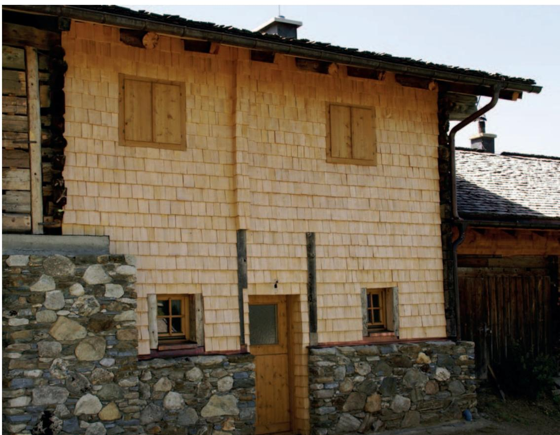
**Fig. 10** Revêtement de façade en bardeaux (shingles).
