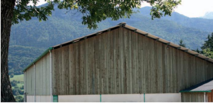
**Fig. 24** Bardage dont le bois a été traité en autoclave au moyen de produits contenant des sels métalliques.
