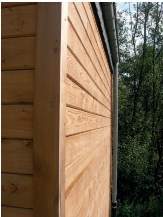
**Fig. 48** Finition latérale du bardage.
