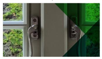
Il convient de prendre en compte la composition des produits pour les projets de construction neuve ou de rénovation, car les composants de quincaillerie de fenêtre peuvent ternir en raison de l'humidité générée par les travaux humides.
