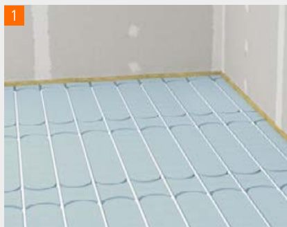
1 Canalisations de chauffage (16 mm) mises en place.
