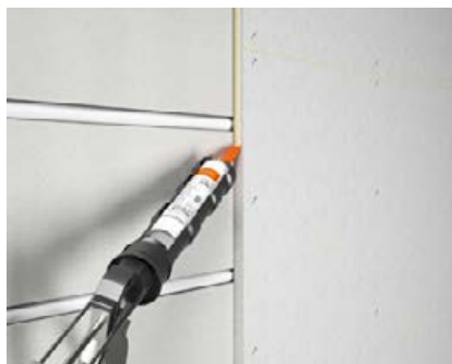
Réalisation des raccords collés
