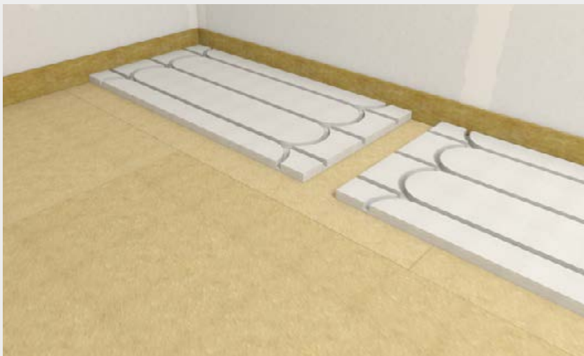
Pose des plaques de sol fermacell® Therm25™ (variante 1), bord à bord, avec joints positionnés en croix.
