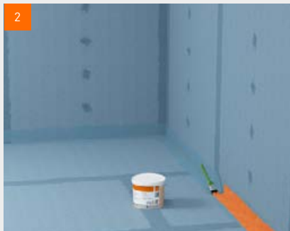
2 Appliquez la membrane d'étanchéité liquide fermacell™ dans les angles
