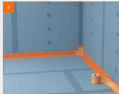
3 Comprimez la bande d'étanchéité fermacell™ dans la membrane liquide encore humide
