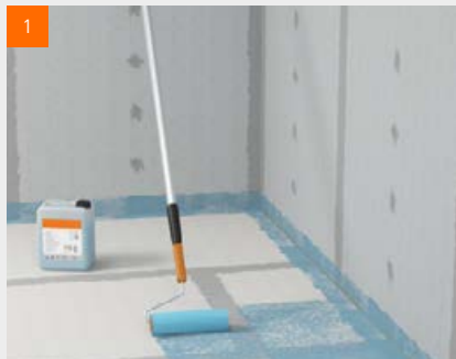
1 Appliquez le primaire fermacell™ au rouleau sur les zones indiquées
