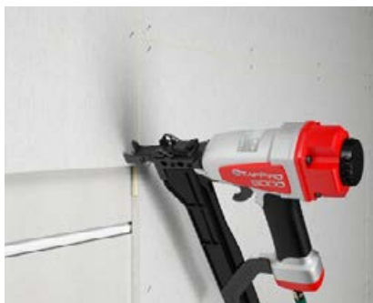
Fixation de la couche supplémentaire de plaques fibres-gypse fermacell® ou Powerpanel H 2 O, avec joint de raccord
