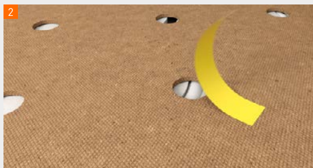
Posez le gabarit à l'endroit où la plaque fibres-gypse fermacell® sera utilisée comme plaque supérieure. Vérifiez la présence de canalisations de chauffage dans les zones de fixation. Si c'est le cas, recouvrez le point de fixation de ruban adhésif.
