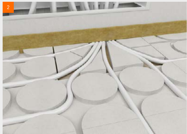
À combler au moyen de chutes de fermacell® Therm25™ ou de granules pour nid d'abeille
