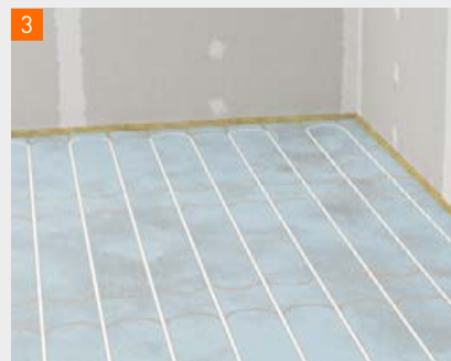
3 Plaques de sol Therm25™ avec mortier adhésif en place.
