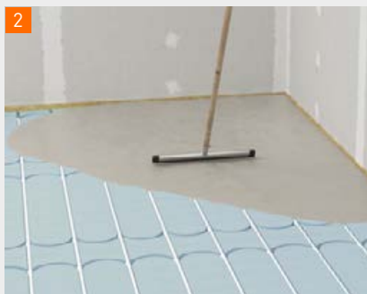
2 Coulage de mortier adhésif fermacell™ sur les plaques de sol Therm25™.
