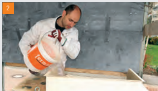
2 Ajouter 8 à 10 litres d'eau par sac
