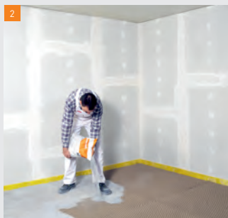
2 Remplir la Plaque nid-d'abeilles fermacell de Granules pour nid d'abeilles fermacell
