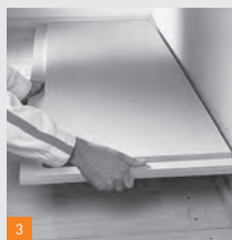
3 Pose de la première dalle
