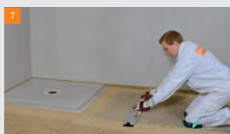
Lorsque le Mortier d'égalisation a été versé entièrement entre les bourrelets, procéder à l'égalisation
