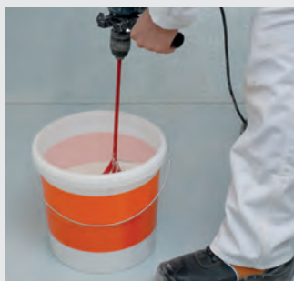
Mélanger dans un seau propre à raison de 6,5 l d'eau par sac de 25 kg
