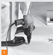
5 Vissage de la languette...
