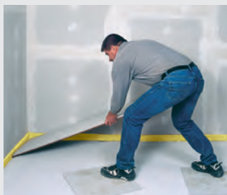
Pose des Plaques de sol
