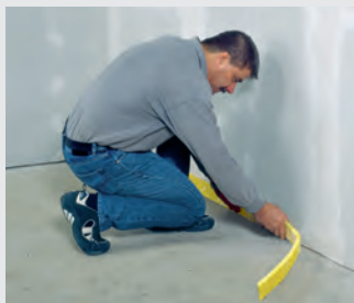
Pose des bandes d'isolation latérales
