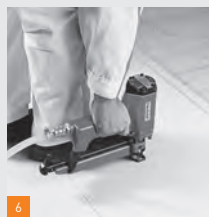
6 ... ou fixation au moyen de rivets spéciaux
