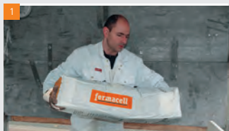
1 Mélanger le contenu d'un sac entier dans la bétonnière
