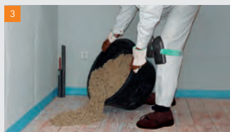
Verser le ciment de ragréage
