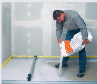
Étalement du granulat
