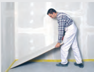
Pose des Plaques de sol
