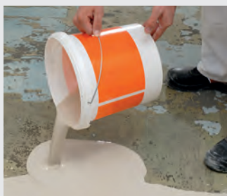
Verser l'enduit
